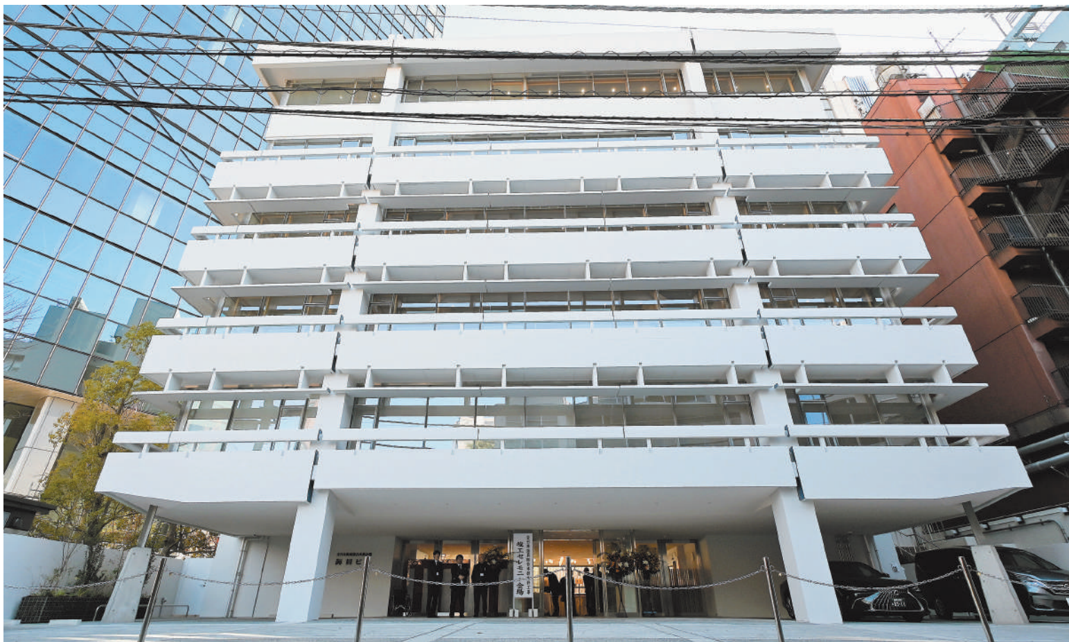
新築当時の意匠を最大限に保存・修復した本部会館・外観
